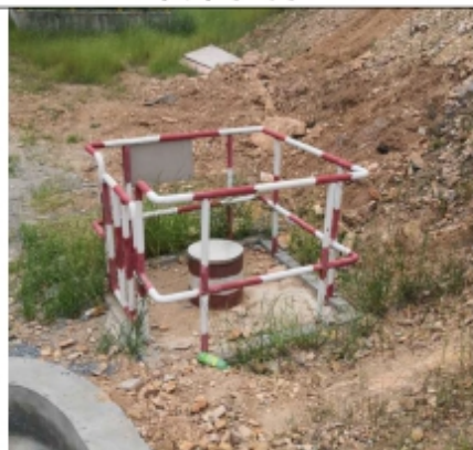
地下水监控井
