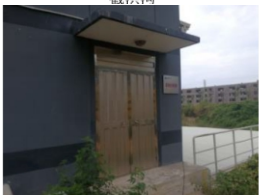
灰场消力池泵房
