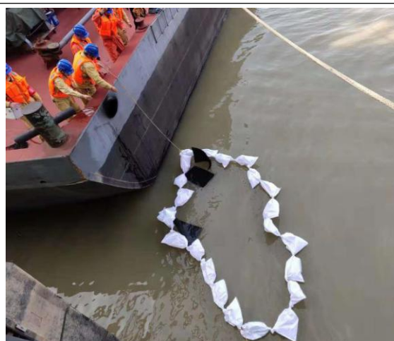
漏油处置完毕，人员撤离
