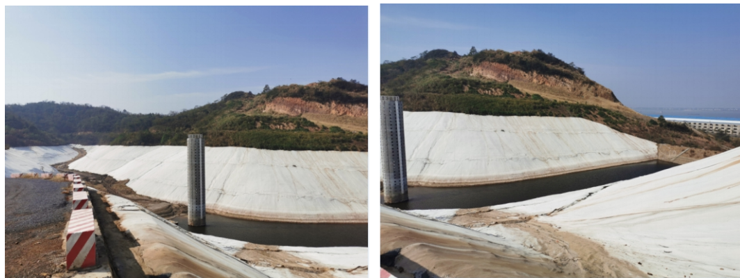
灰场现状照片
