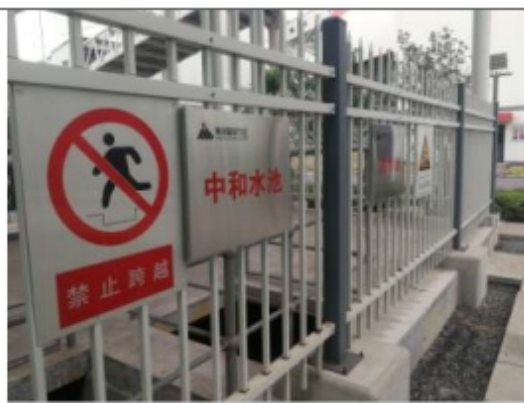
中和水池及浓水池
